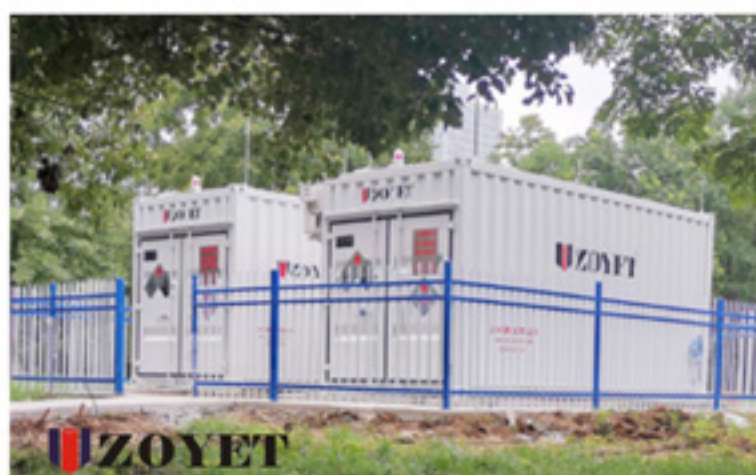
明基医院项目
