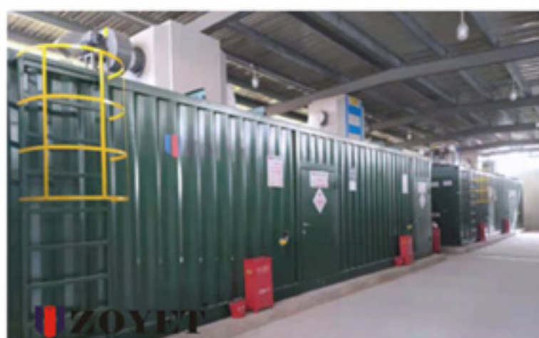
上海理工大学二期项目
