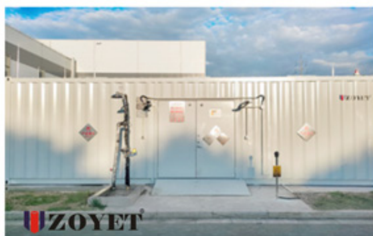
环晟光伏项目
